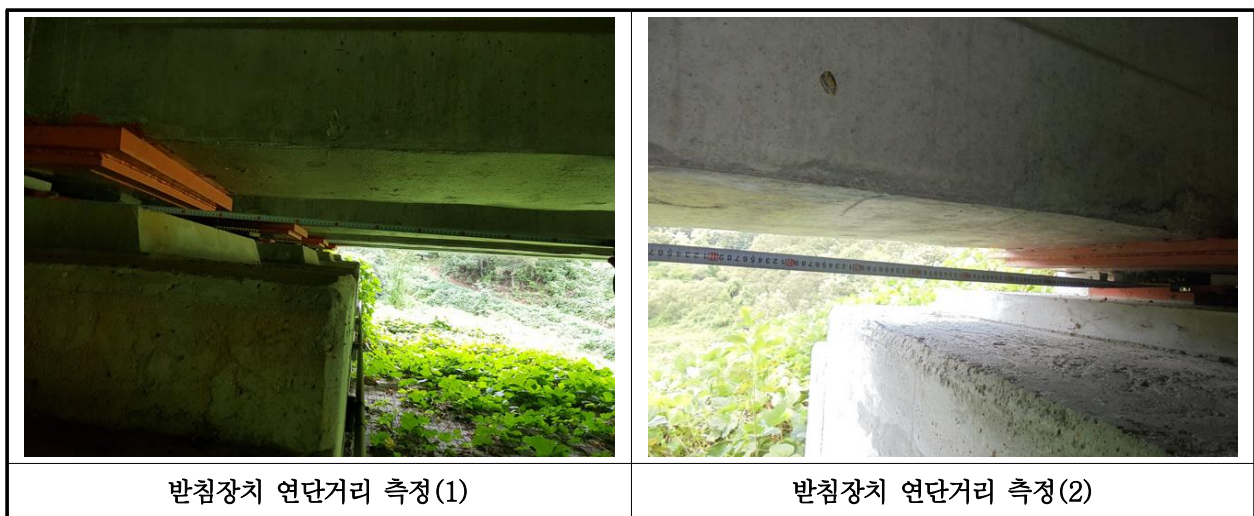
【사진 11.3.42】 교량받침장치 연단거리측정
