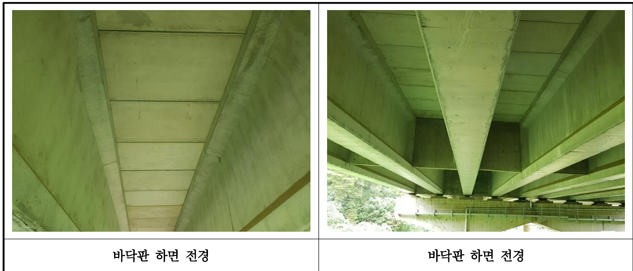
【사진 11.3.29】바닥판하면 전경
