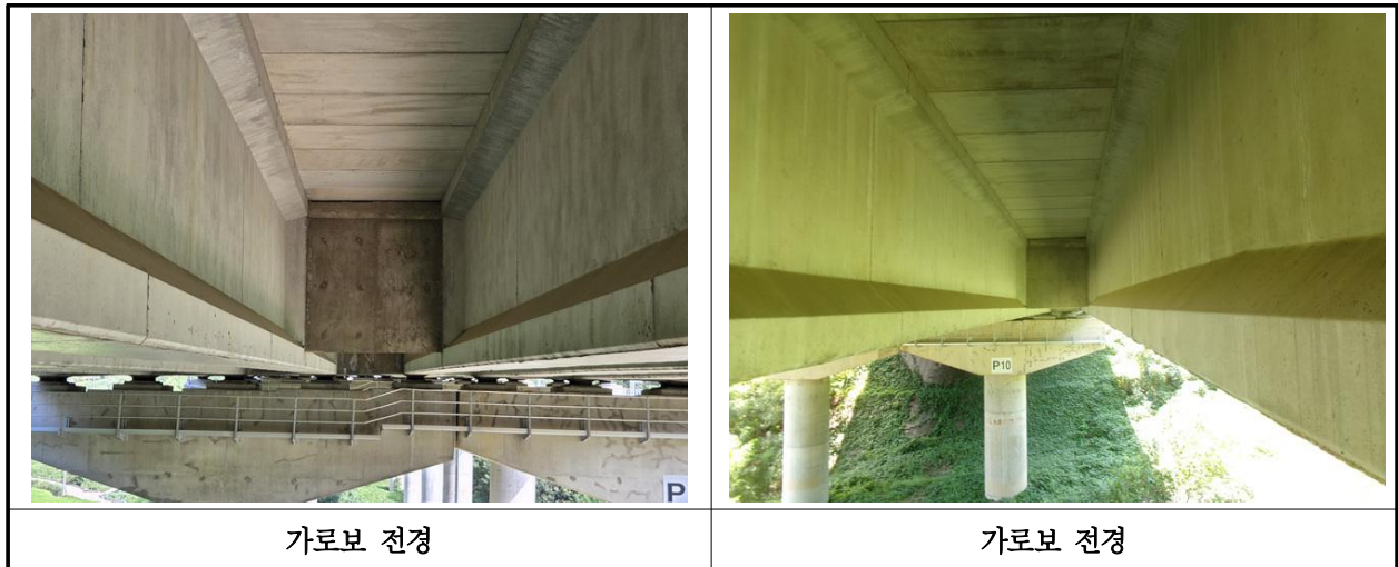
【사진 11.3.33】 가로보 전경
