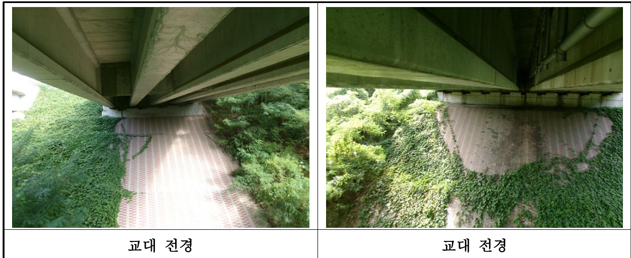
【사진 11.3.8】 교대 전경
