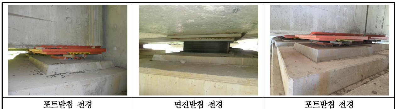
【사진 11.3.13】 교량반침 전경
