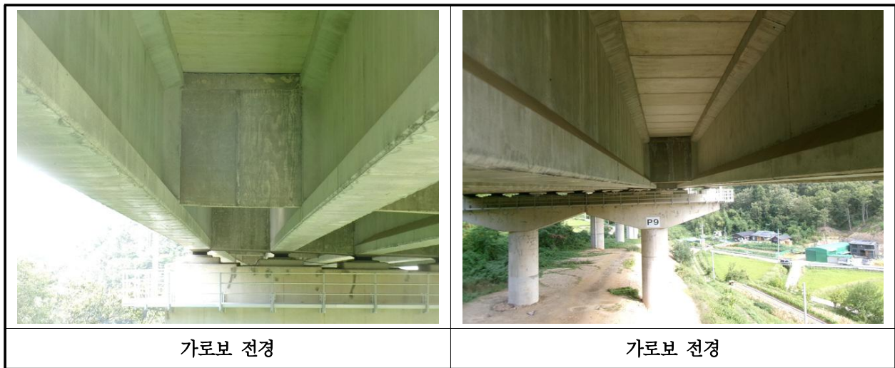
【사진 11.3.6】 가로보 전경
