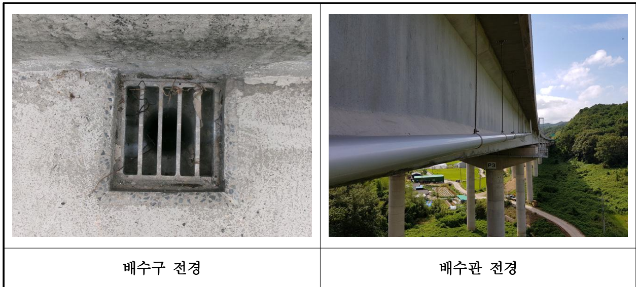
【사진 11.3.49】 배수시설 전경
