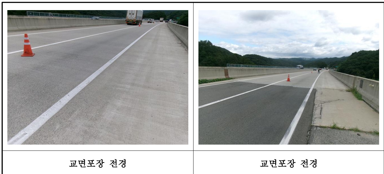
【사진 11.3.47】 교면포장 전경
