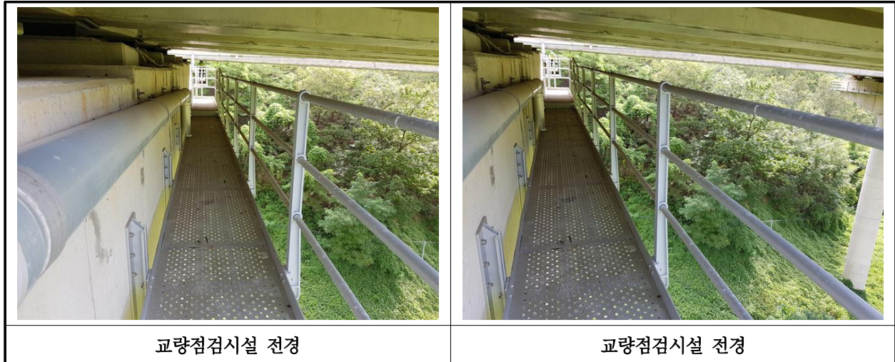
【사진 11.3.53】 교량 점검시설 전경
