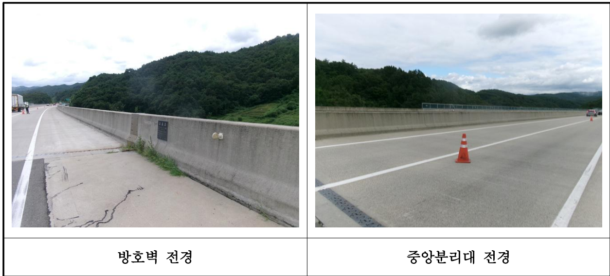
【사진 11.3.51】 방호벽 및 중앙분리대 전경
