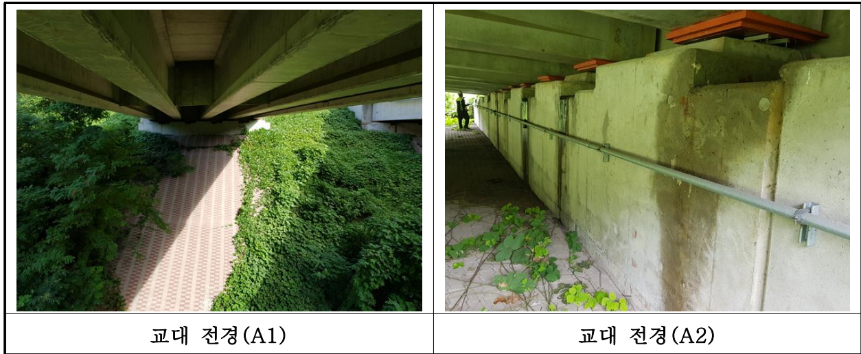
【사진 11.3.35】 교대 전경
