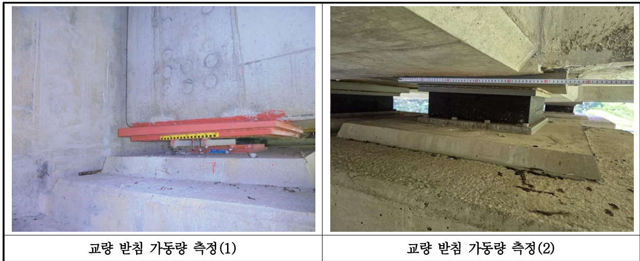
【사진 11.3.43】 교량받침 이동량 측정
