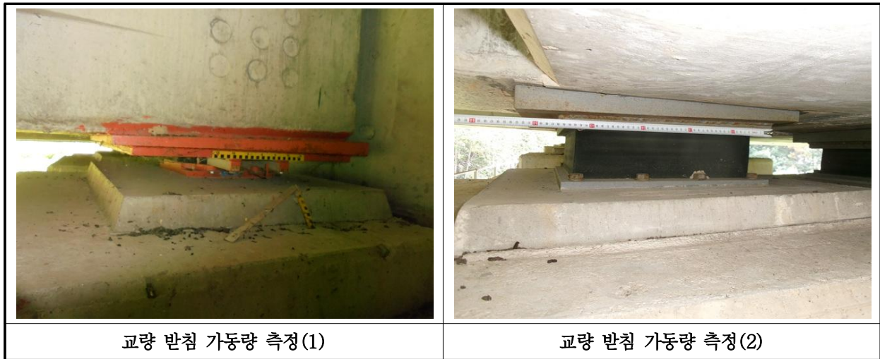
【사진 11.3.16】 교량받침 이동량 측정
